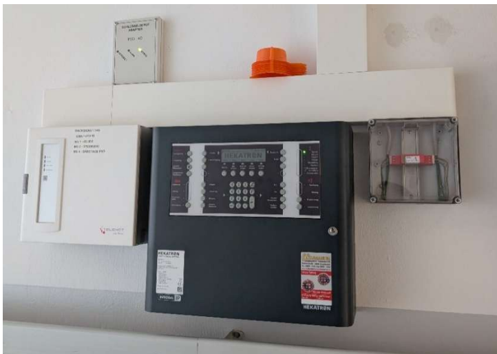
Abbildung 4 - Brandmeldezentrale + Übertragungseinrichtung + FSD
